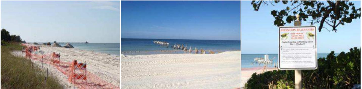
Die Erweiterung des Strandes in Naples ist in vollem Gange. Danach sollen grosse Abschnitte des Strandes 20 m breiter sein. Der Sand wird aus dem Landesinneren per LKW angeliefert. Insgesamt werden das ca. 10.000 Ladungen sein. Der Sand wird durch Wellen und Stürme innerhalb von 5 Jahren wieder in das Meer geschwemmt. Das Projekt kostet ca. 10 Millionen und wird aus den Einnahmen der Kurtaxe finanziert. Die Arbeiten am Vanderbilt Beach werden bereits im November abgeschlossen.
