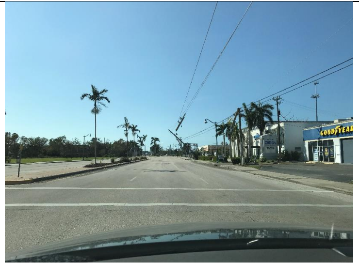
Strommasten am seidenen Faden an der US 41 East
